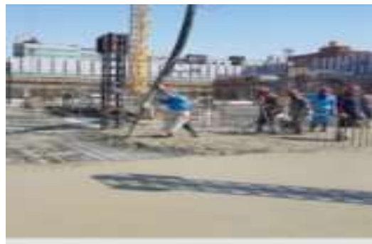
⑤ 콘크리트 타설
