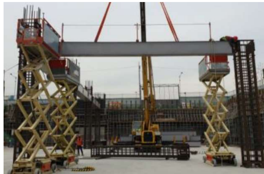
② 기둥(2개층) + 보 설치
