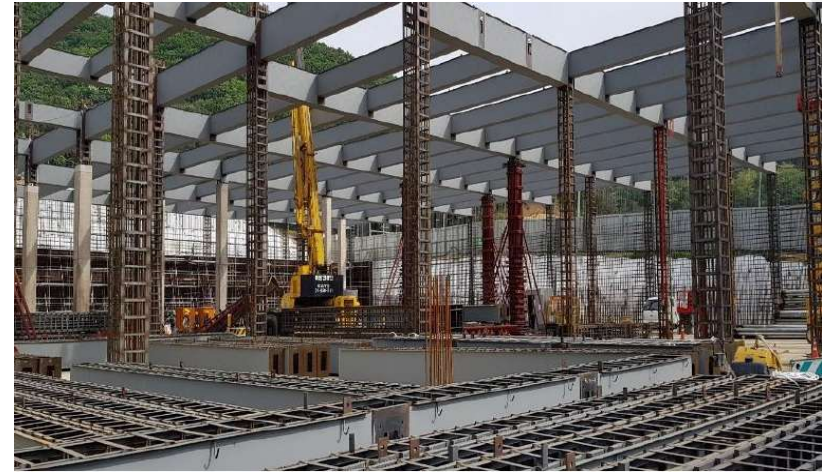
현장에서 조립, 설치 및 콘크리트 타설
