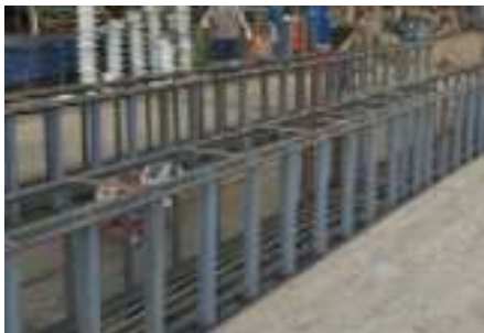
② 1차 조립 및 용접
