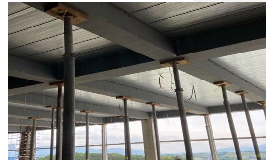
③ 잭서포트 설치
