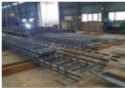
② 면조립 용접
